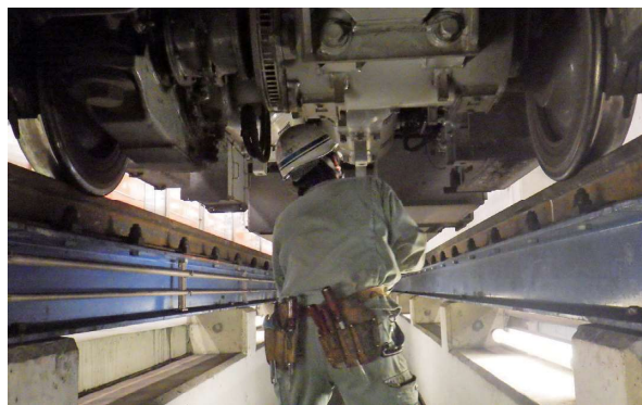
地下鉄車両整備・点検の様子
