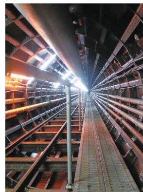
雨水幹線整備
