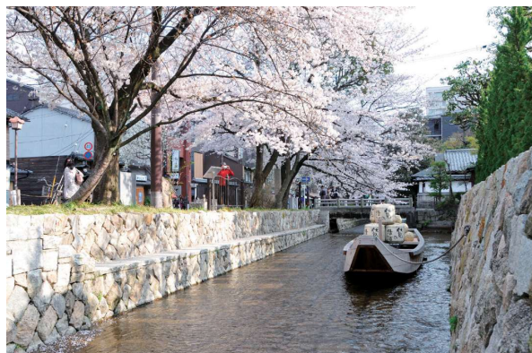
高瀬川改修後の風景
