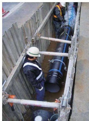
配水管布設替え
