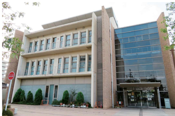
区役所・支所総合庁舎
